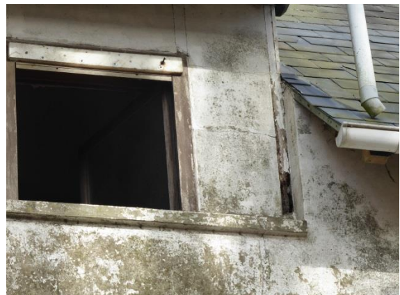
24. Februar 2021: Dachschaden, kaputte Fenster, rissige nasse Wände, Fraßgänge im Fachwerk
