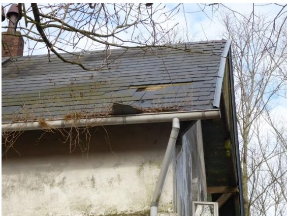
24. Februar 2021: Dachschaden, kaputte Fenster, rissige nasse Wände, Fraßgänge im Fachwerk
