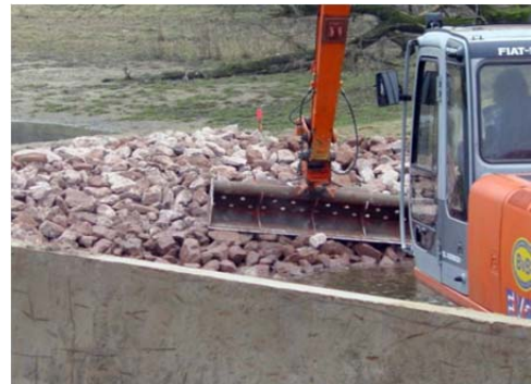
Baggerarbeiten an der Mittleren Elbe © Mirko Pannach / WWF
