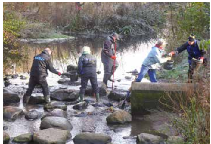
Einbringen von Kies in die Wandse
