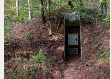
Ein ehemaliger Pumpenkeller auf dem Gelände konnte zu einem Fledermauswinterquartier umfunktioniert werden. Er wurde erstaunlich schnell angenommen.
