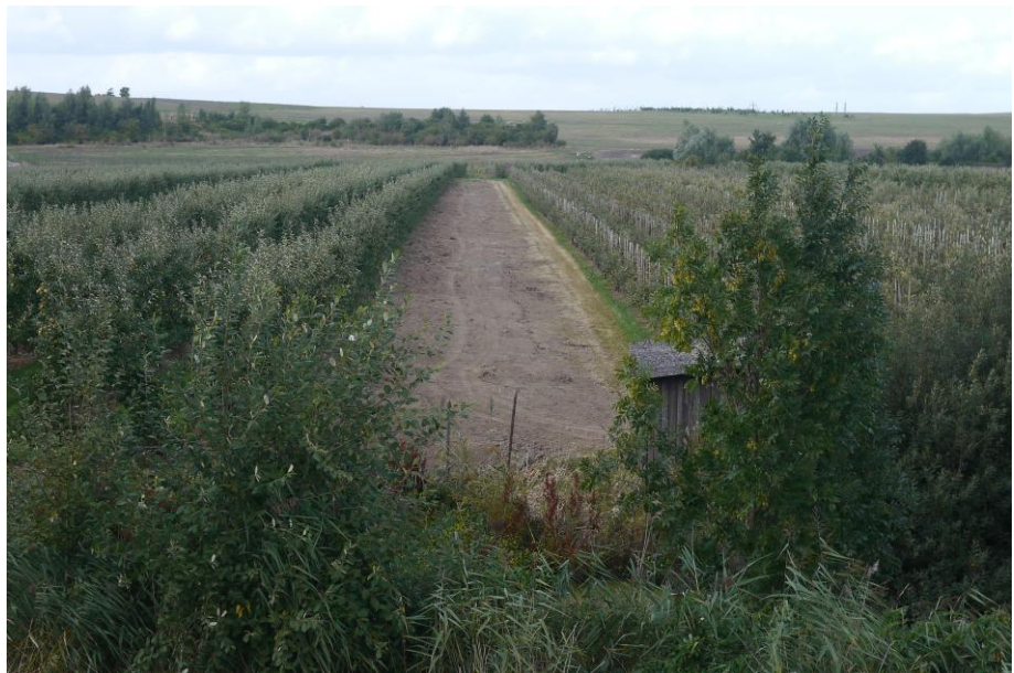
Illegal zugeschütteter Graben (hinten Schlickhügel Francop)
